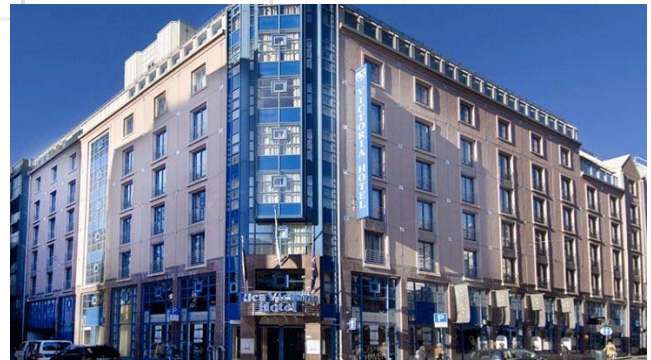
Instalación de 2 Sistemas en Hotel Victoria (cadena Rica Hotels – Oslo)
