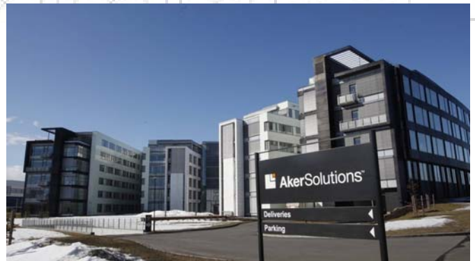
Instalación de 4 Sistemas CAS en la empresa Aker Solutions (Stavanger)
